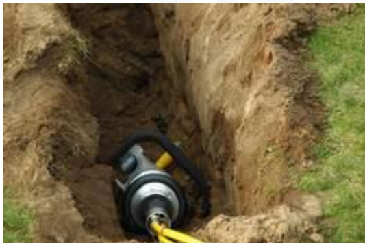
Mit dem hydraulischen Spreizer abgedichtete Gasleitung
